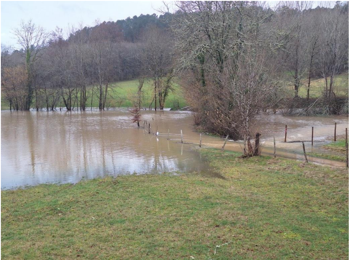
Figure 10. Couzeau en crue à la suite de la tempête Nils.
