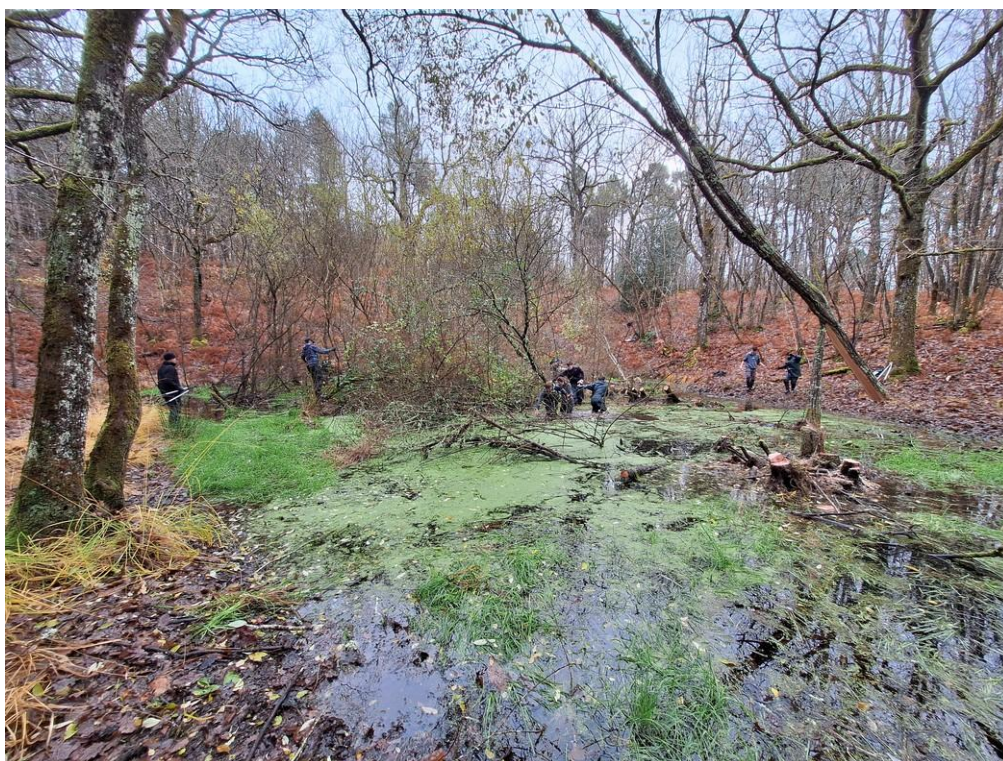
Figure 3. Travaux des GMNF sur la mare.
